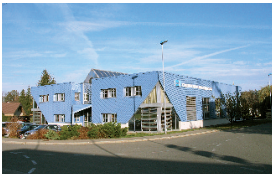
Le bâtiment de l'entreprise Construction Inoxydables SA à Châtel St-Denis
